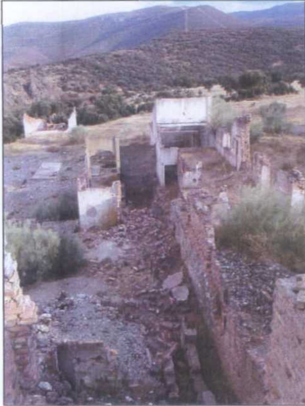
LP008.- Ruinas del lavadero de minerales.
