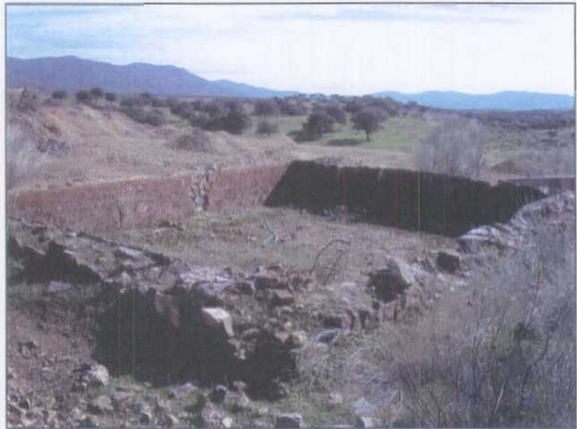
EB006.- Antiguo depósito de recogida de agua del bombeo de la mina.
