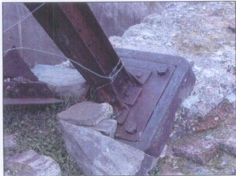
RB001.- Castillete metálico del pozo. Zapata metálica de apoyo de un pie delantero.
