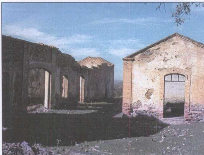
DG026.- Edificios auxiliares del Pozo nº 3.
