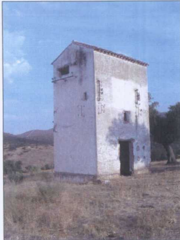
LP005.- Caseta del transformador eléctrico.
