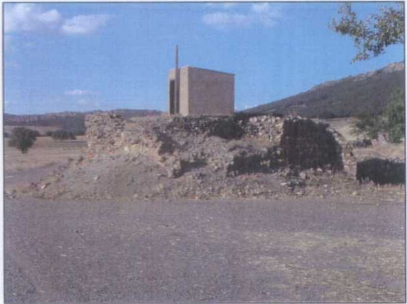
LV004- Restos del pozo n° 4.
