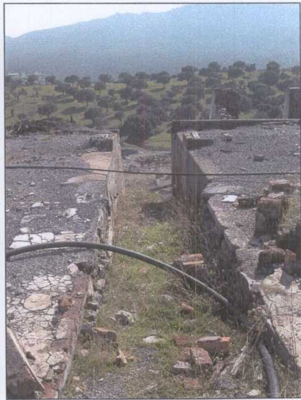
DG016.- Plano inclinado de vagonetas para carga y transporte de estériles del lavadero al pozo.
