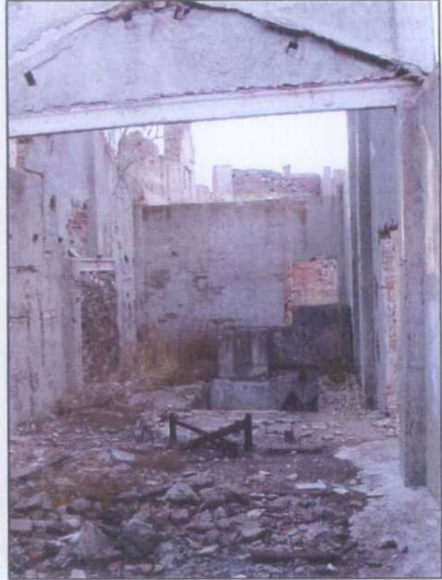
LP004.- Interior del lavadero de minerales. Restos de banquetas y soportes metálicos de una cinta transportadora.
