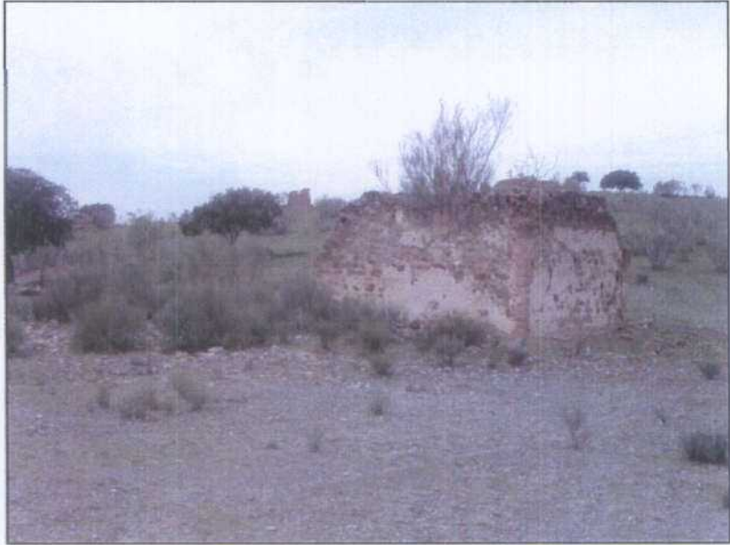
GJ018.- Estructura del pozo de lenate. Se encuentra cegado.
