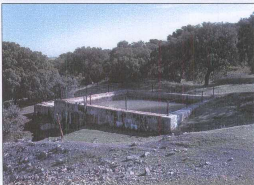
DG026.- Depósito de recogida de agua del bombeo del pozo nº 3.
