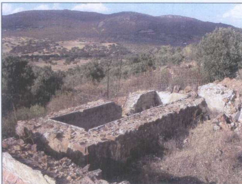
ST002.- Depósito de recogida de aguas del bombeo de la mina.
