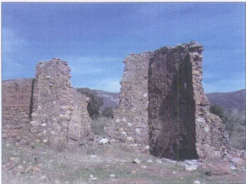
EB010.- Restos de un baritel utilizado para la extracción del pozo nº 1, que era el situado más a levante de la mina.
