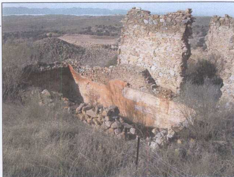
GT005.- Depósito exterior de recogida del agua del bombeo.
