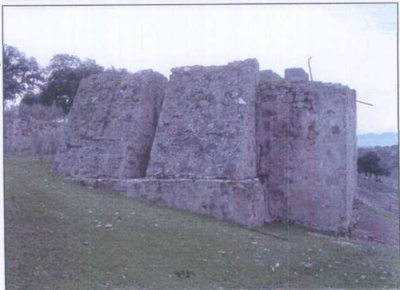
GJ002.- Estructura del pozo Maestro o principal de la mina. Vista delantera.
