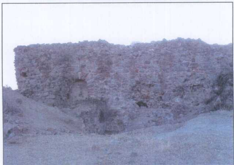
EP003.- Tolva de volcado de minerales para alimentación del lavadero. Vista frontal.
