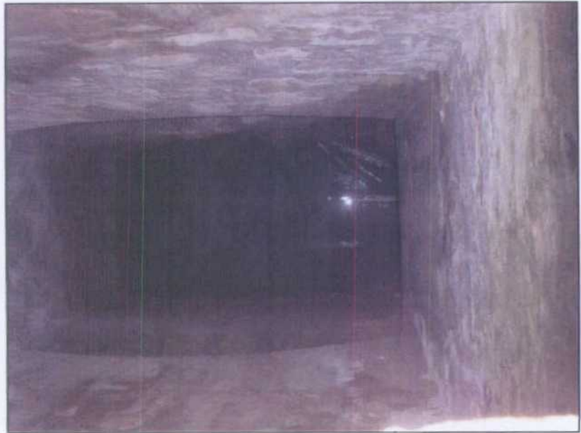
PZ002.- Pozo Maestro de la mina. Vista de la caña del pozo.
