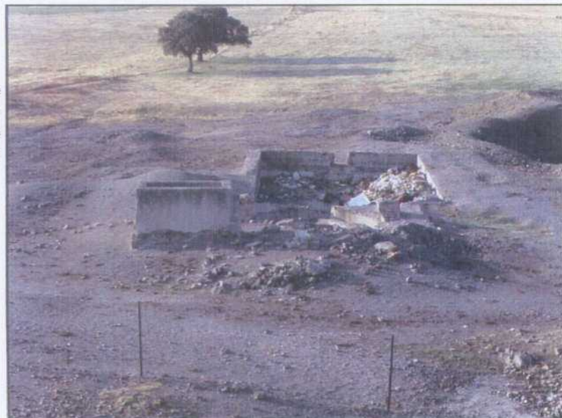
TV005.- Restos del lavadero de minerales. A la vista aparecen principalmente instalaciones del intento de relavado de los años 1950.
