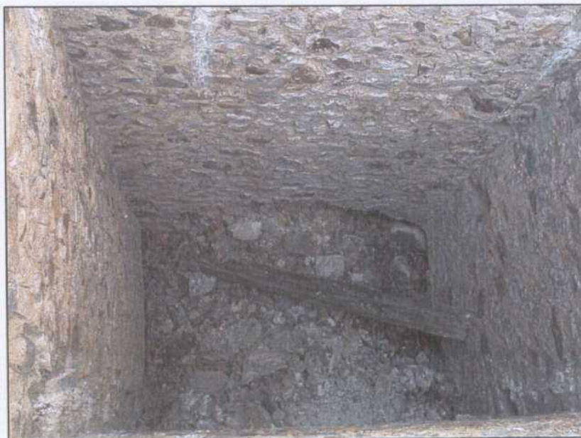
LV007.- Caña del pozo n° 3. Se encuentra cegado a los pocos metros de su emboquille.
