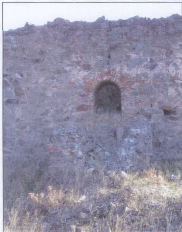
EM006.- Tolvas de descarga de minerales junto al pozo de po niente. Detalle de la compuerta.
