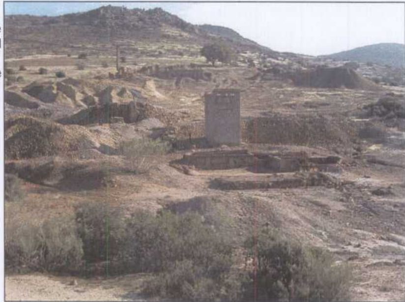
GT002.- Restos del lavadero de flotación. Se ve la caseta del transformador, canales de decantación y bancadas de machacadora y molienda.
