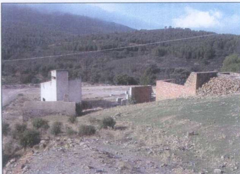
EH009.- Restos del lavadero de mineral de los años 50. Se ve la caseta del transformador eléctrico y delante una curiosa construcción de uso desconocido. A la derecha están las tolvas y zona de molienda.
