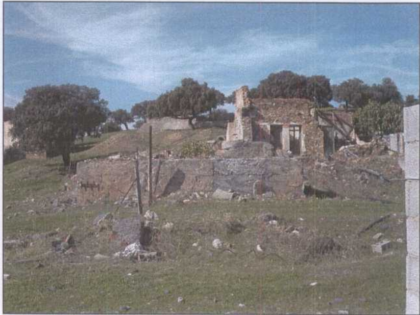
DG017.- Restos de la casa de máquinas del pozo nº 1.
