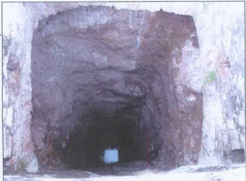
GJ008.- Pozo de extracción antiguo. Vista de la caña del pozo.
