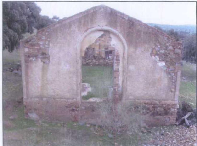
PZ003.- Casa de máquinas del pozo Maestro. Vista de la fachada frontal.
