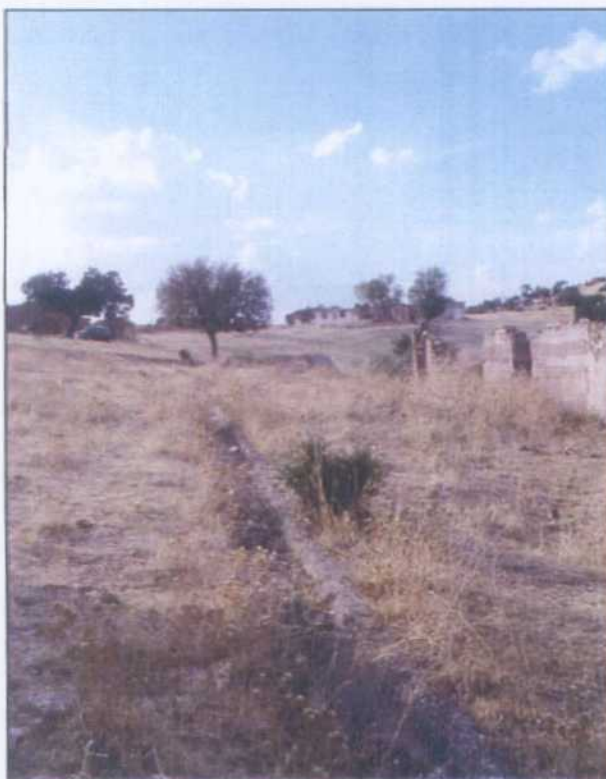
LP002.- El agua era llevada desde el depósito hasta el lavadero mediante una canalización en el suelo.
