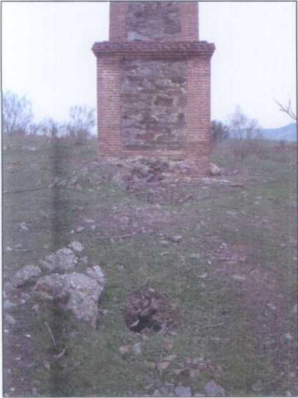
SB001.- Chimenea de humos. Base de la Chimenea y conducción subterránea de humos.
