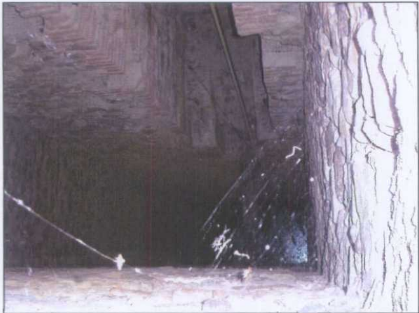
LV004.- Caña del pozo n°4.
