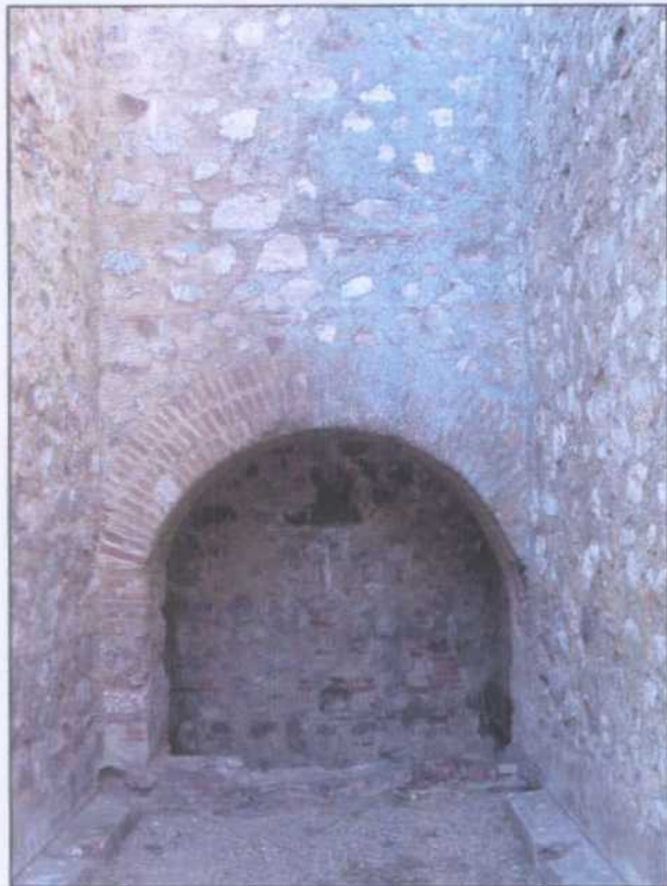
EM003.- Pozo San José. Embarque frontal a nivel de superficie.
