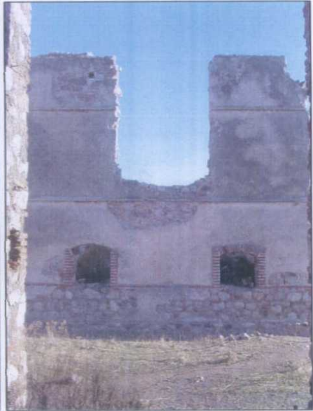
EM002.- Casa de máquinas del pozo San José. Vista delantera.
