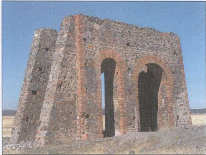
DL001- Estructura superficial del pozo de la mina. Vista lateral.
