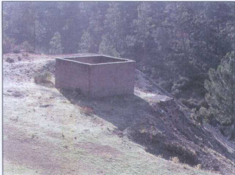
EH005.- Brocal de protección del pozo Postdata.
