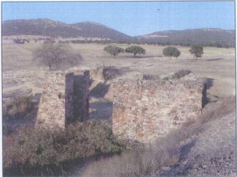
EP002.- Pozo La Perrera de la mina Apeles.
