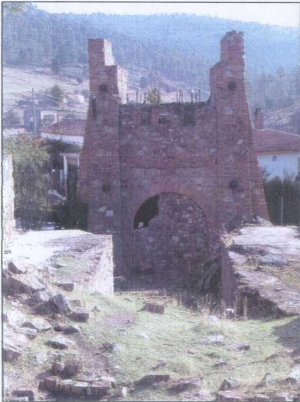
EH006.- Vista delantera del pozo San Miguel. En primer término se ven los restos de la casa de máquinas.
