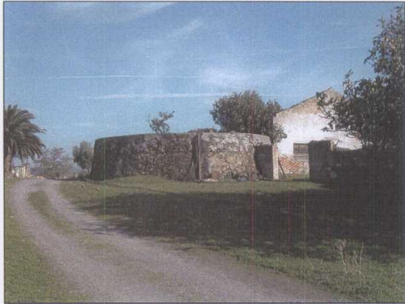
DG009.- Depósitos de agua potable.
