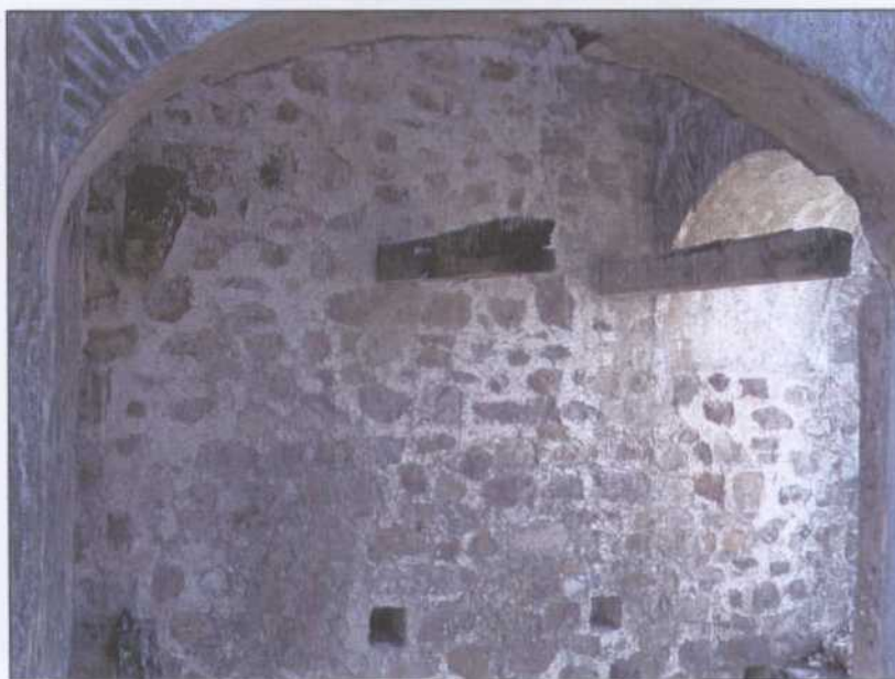
RM010.- Detalle del embarque en superficie del pozo San Lorenzo. La salida lateral era la del auxiliar de escalas.
