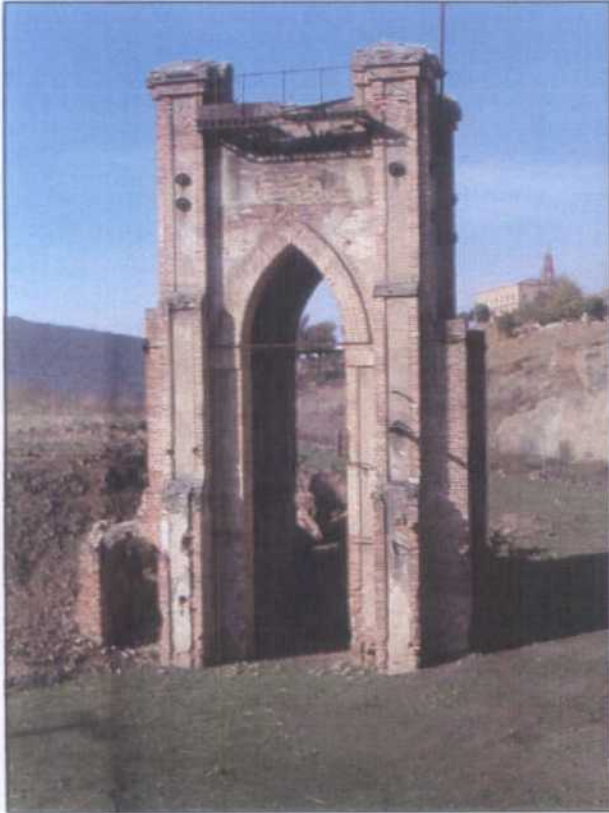
EH004.- Espectacular cabria de ladrillo y mampostería del pozo Argentino. Vista frontal.
