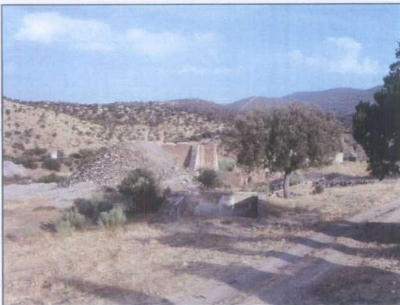
LP002.- Depósito de recogida de agua del bombeo de la mina para su uso posterior en el lavadero. Detrás del depósito se puede ver el pozo Mi Angel.
