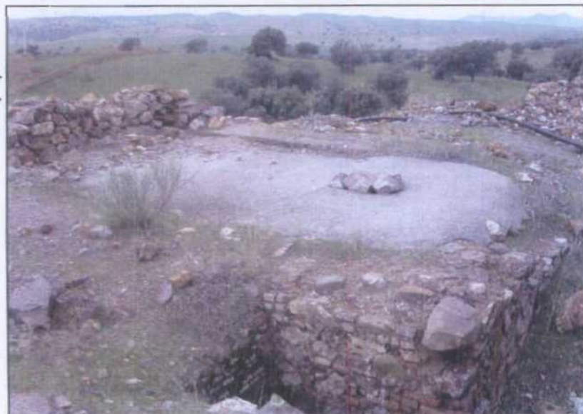
PZ002.- Pozo Maestro de la mina. Vista del emboquille tapado con una losa de cemento.
