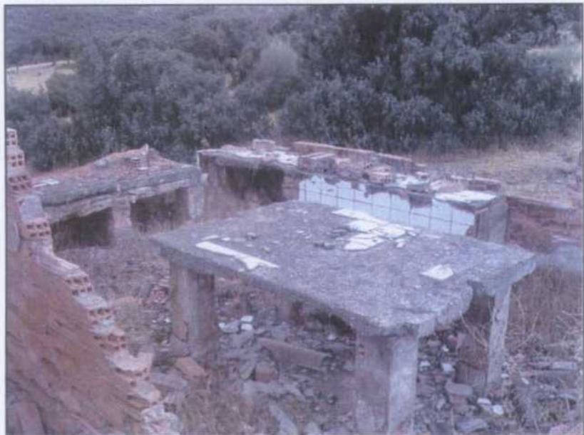
LP006.- Ruinas del comedor y vestuarios.
