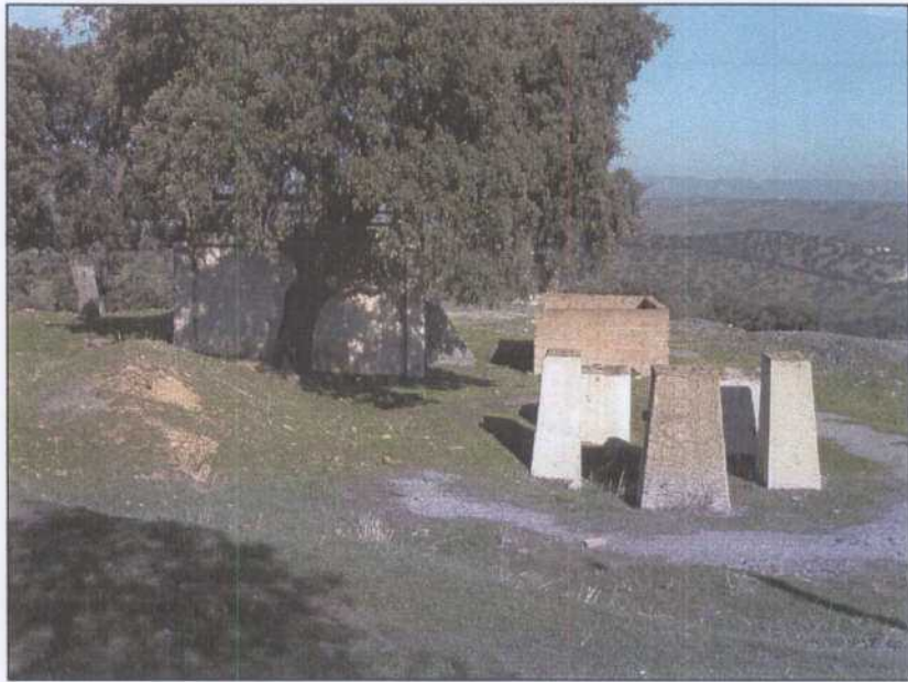
DG025.- Apoyos del retorno del cable de vagonetas tras volcar el material para el relleno.
