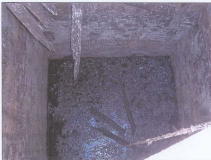
RM006.- Vista de la caña del pozo Santa Bárbara.
