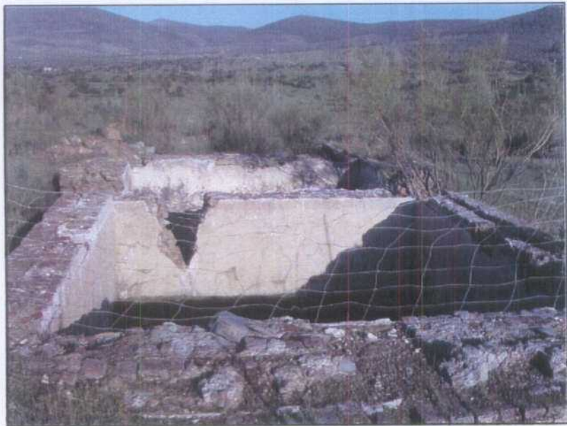
FL002.- Depósitos de recogida del agua del bombeo de la mina.
