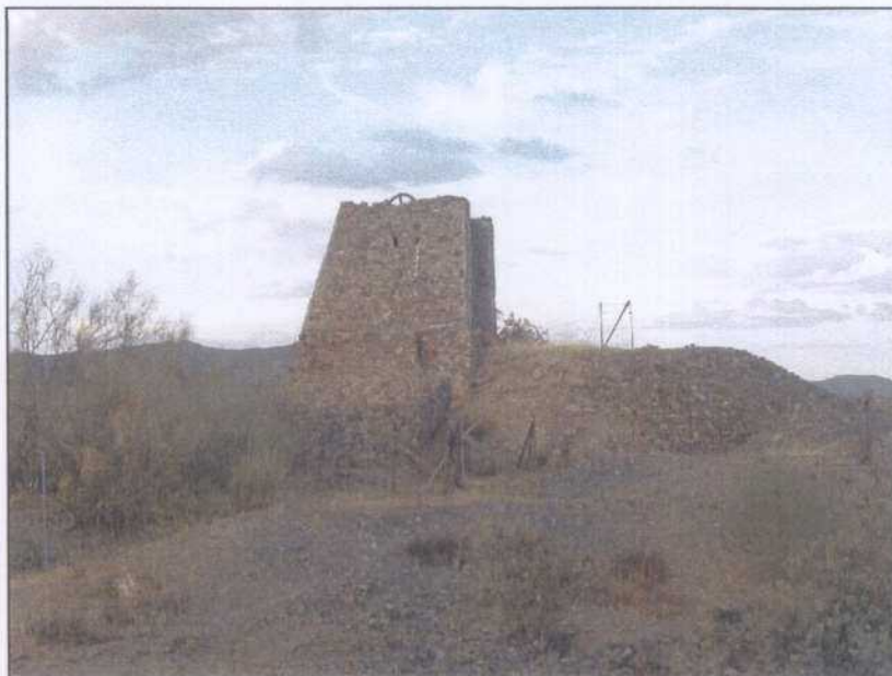
LJ013.- Cabria de mampostería del pozo Buen Acuerdo.
