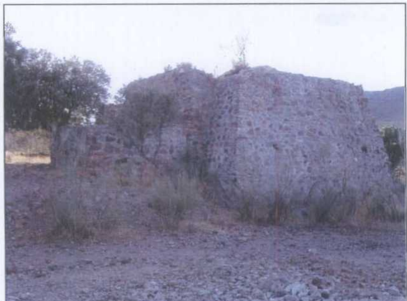
LJ002.- Vista trasera de la estructura del pozo Esperanza.
