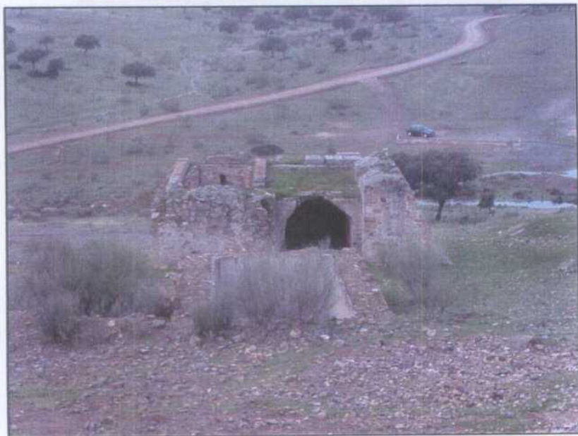
GJ002.- Pozo Maestro o principal de la mina.
