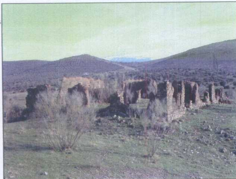
FH004.- Ruinas de edificaciones de la mina.
