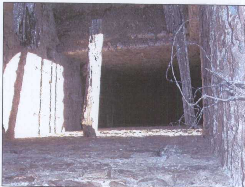
RM002.- Vista de la caña del pozo San Mauricio.
