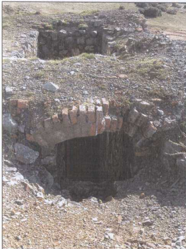
VE001.- Pozo Maestro de la mina. Salida lateral del auxiliar de escalas.
