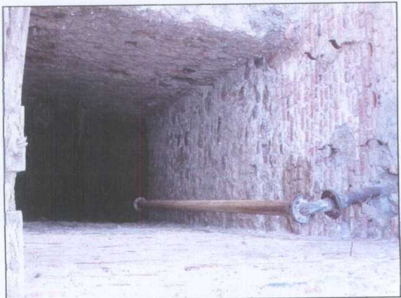
LP003.- Vista de la caña del pozo Mi Angel.
