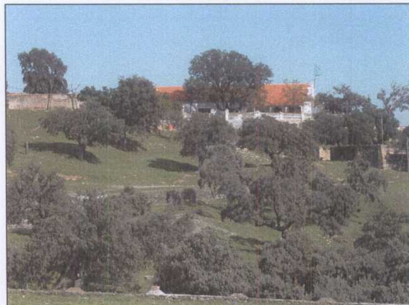
DG007.- Casa de la dirección de la mina. Esta casa está siendo habitada por la propiedad actual de la finca
