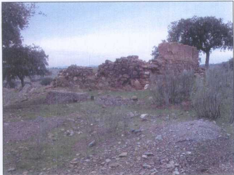
GJ016.- Restos de la casa de máquinas del pozo principal de la mina.
