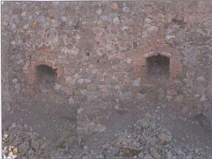
GT003.- Lavadero antiguo. Muros de las tolvas de mineral. Boca de salida de la tolva.
