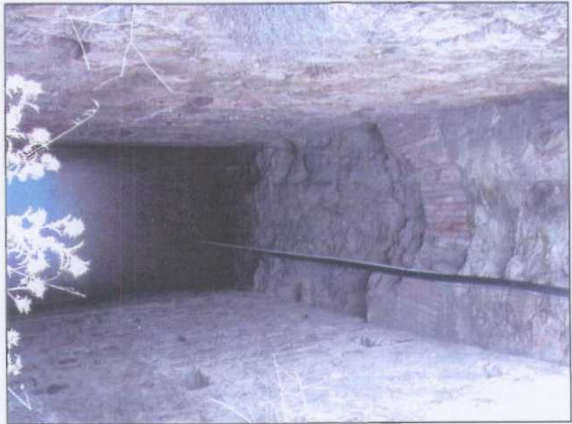
VB002.- Pozo Pepito. Caña del pozo.
