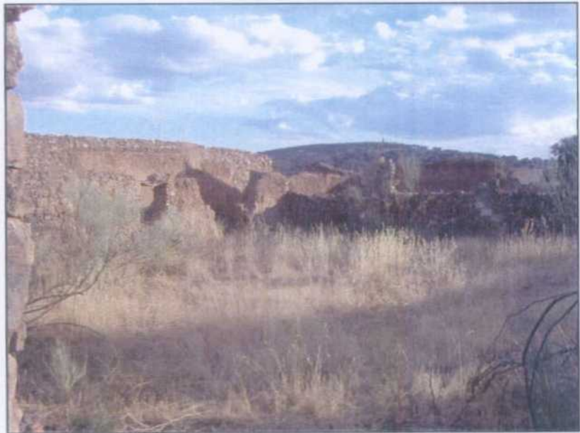
LJ001.- Patio interior del recinto de cuarteles y viviendas de obreros.
