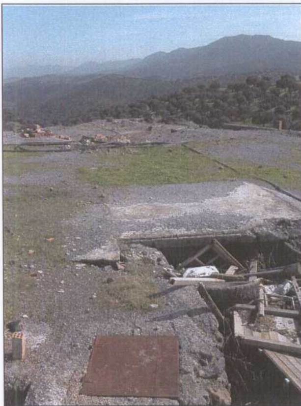
DG016.- Fosos del embarque semi-automático de vagonetas.
