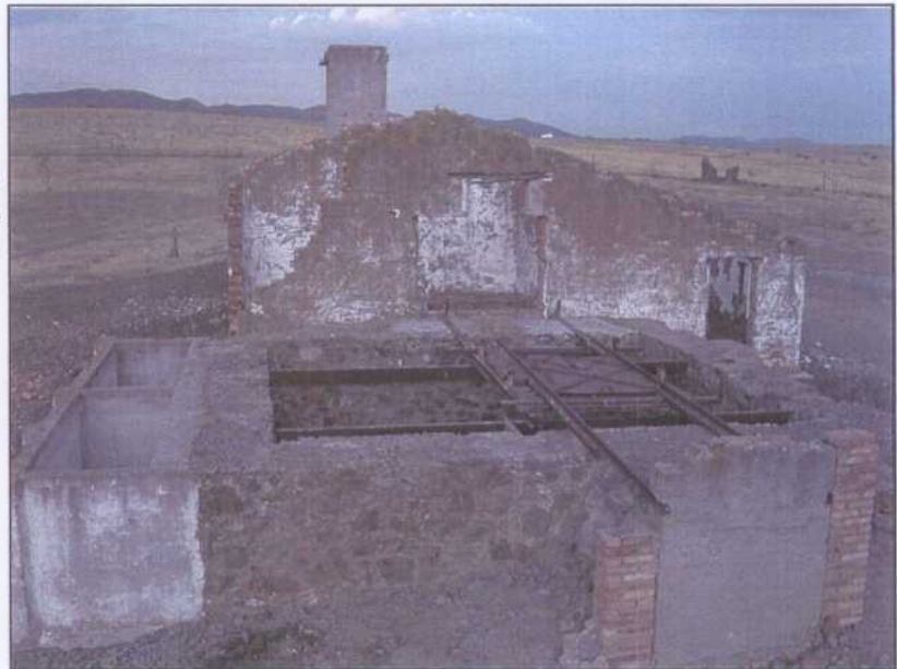
LS001.- Pozo principal de la mina. Sobre el emboquille se conserva los carriles del sistema de descarga de la cuba.
