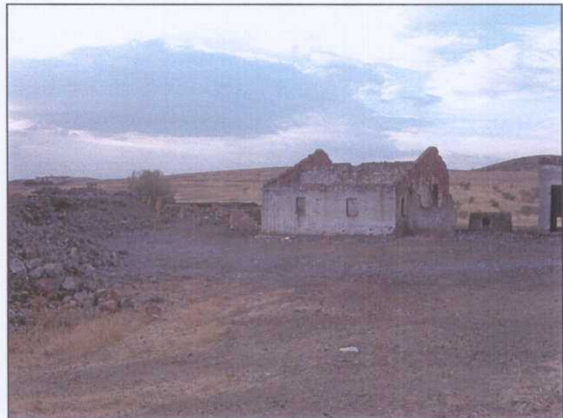
LS002.- Restos de la casa de máquinas del pozo principal.
