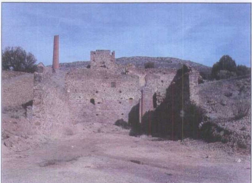
VB010.- Lavadero de minerales. Zona de tratamiento de finos.
