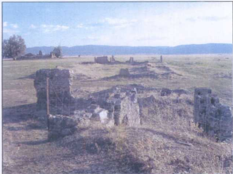
EM005.- Restos de la casa de máquinas y otras edificaciones del pozo de poniente.
