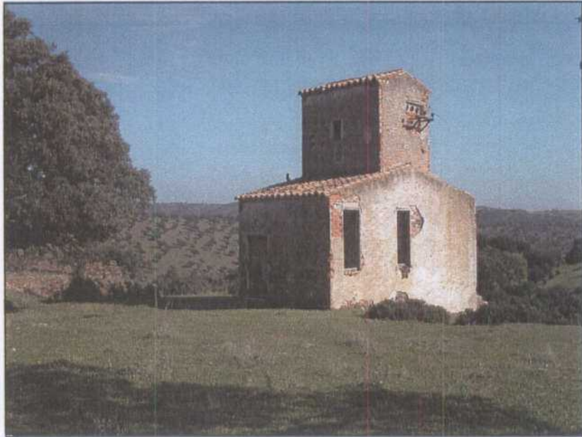
DG028.- Pozo nº 5. Caseta del transformador eléctrico.
