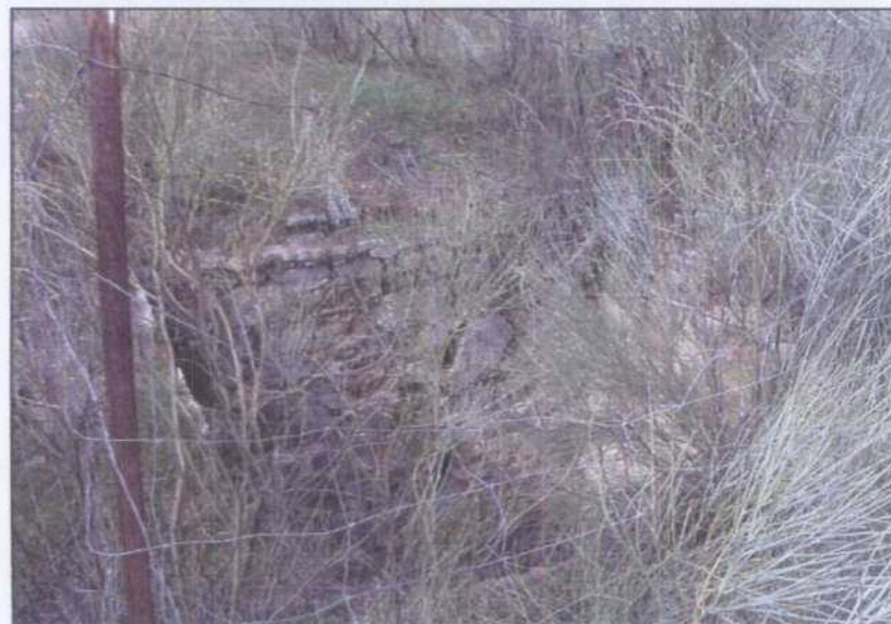
GJ026.- Emboquille del pozo Central. se encuentra muy tapado por retamas.
