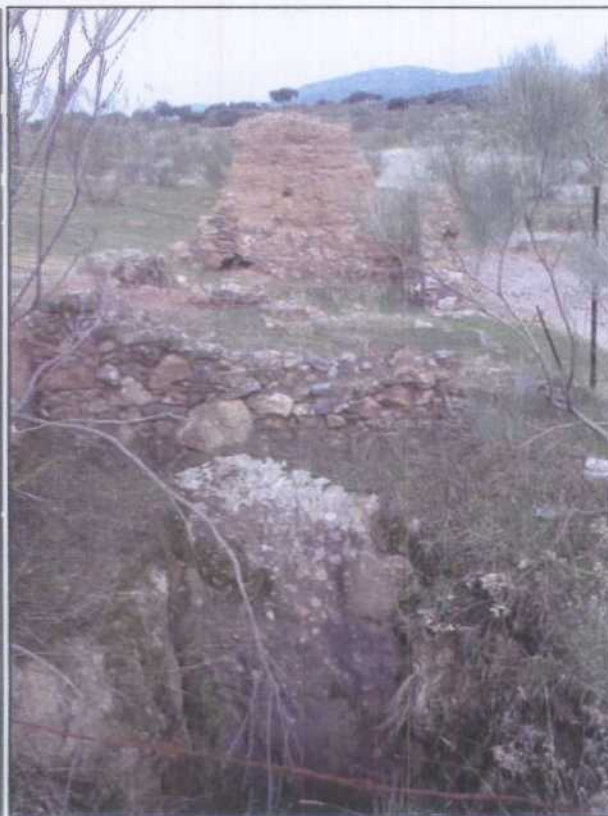
GJ028.- Calderilla realizada sobre filón. Conserva restos de una edificación que debía albergar un cablestante.
