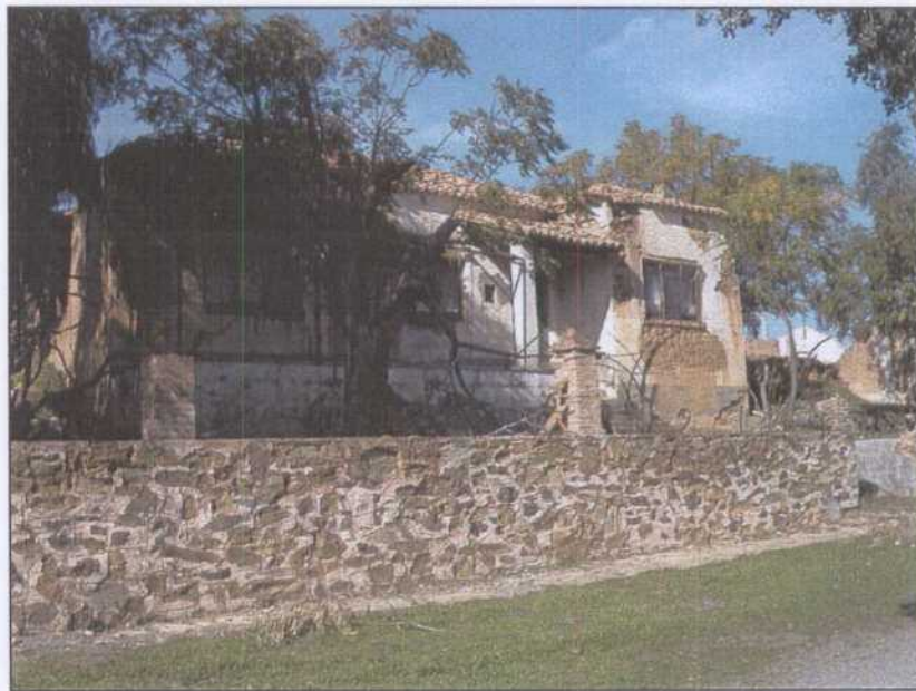
DG006.- Casa de personal técnico de la mina.
