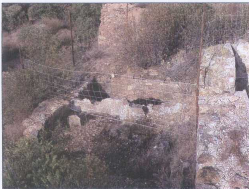
ST003.- Pozo Maestro de la mina Santa Teodora.
