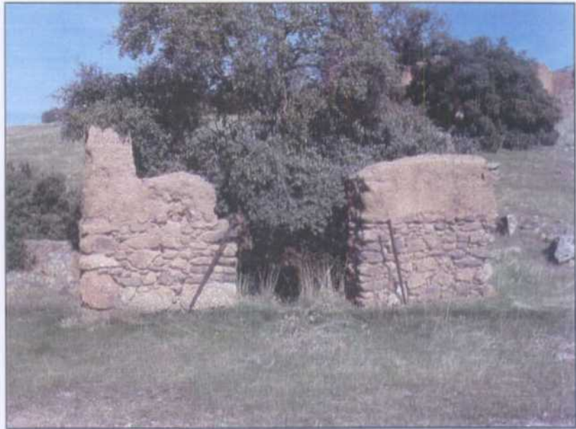
VB003.- Pozo Luisito, utilizado como ventilación.
