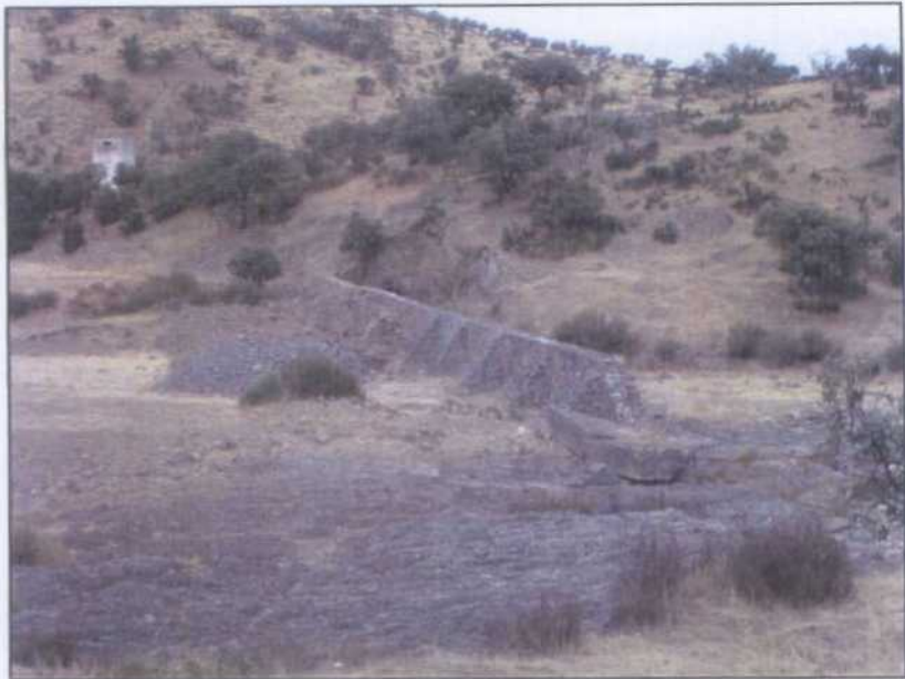
LP007.- Presa y túnel de desvío del río Tablillas.
