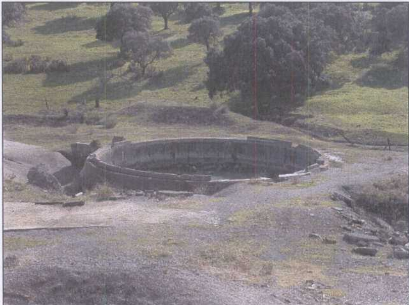
DG022.- Tanque espesador de lodos estériles.
