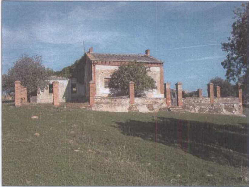
DG008.- Casa del ingeniero de la mina.
