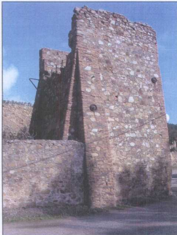
EH006.- Vista lateral del pozo San Miguel.
