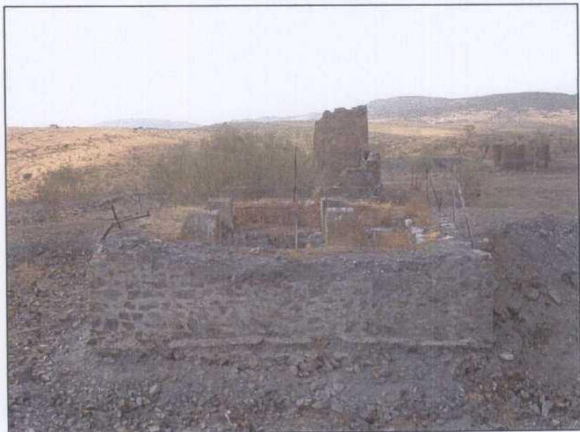
LH007.- Vista trasera de la estructura del Pozo Armstrong.
