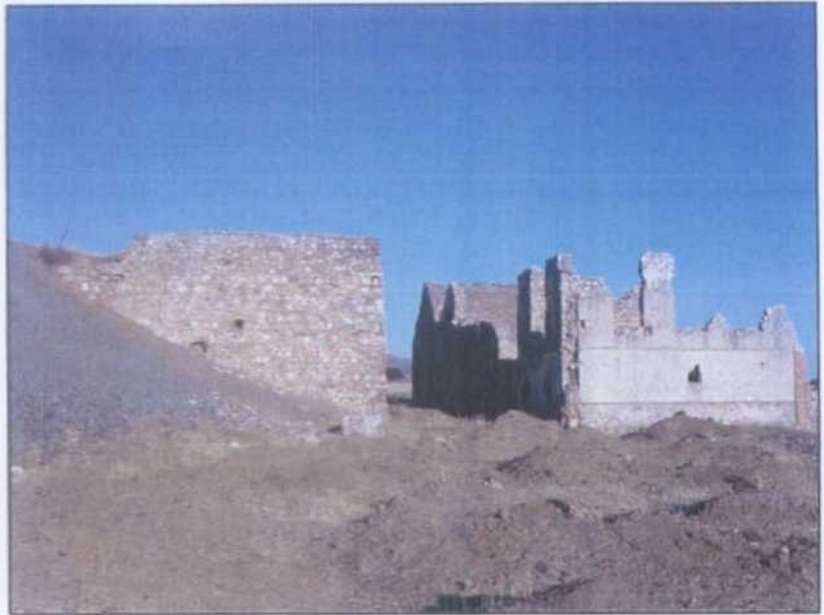
EM003.- Pozo San José. Vista lateral de la estructura de mampostería posterior del pozo.
