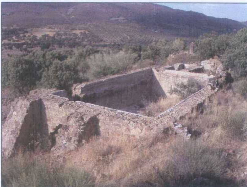
ST001.- Depósito de acumulación de aguas del bombeo de la mina.
