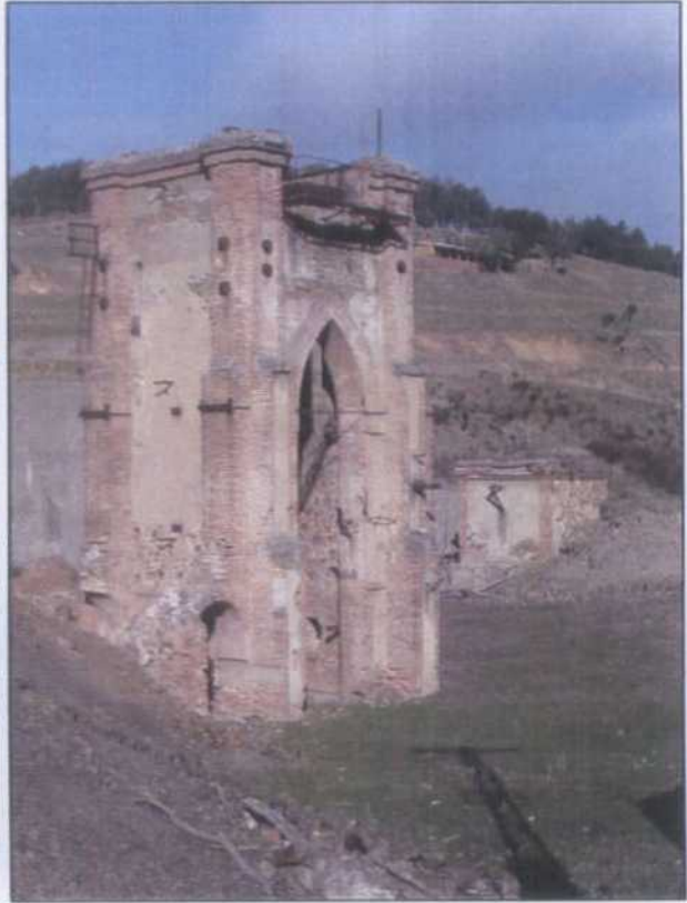
EH004.- Vista lateral de la cabria de ladrillo y mampostería del pozo Argentino. En la parte de la derecha se puede ver la base de una chimenea de humos.
