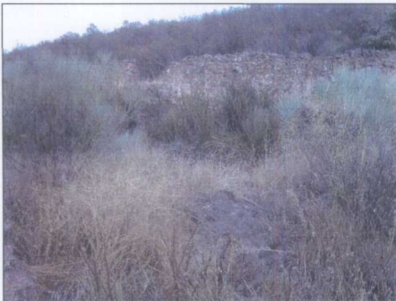
ML004.- Ruinas de instalaciones de la mina Luís.
