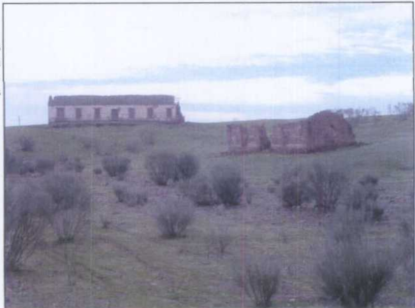
SB003.- Ruinas de edificaciones de la mina. Enfrente se ve la casa del Rasillo, que fue en origen las oficinas viviendas de la mina. T
