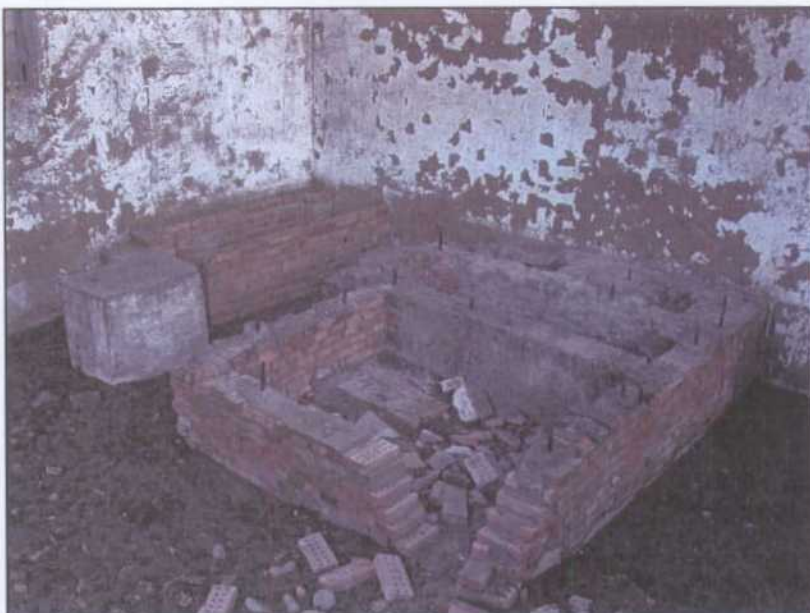
LS002.- Bancada de apoyo del cablestante de la máquina de extracción del pozo principal.
