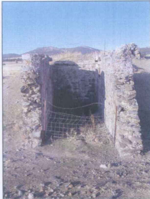
EM004.- Embarque frontal del pozo de poniente.
