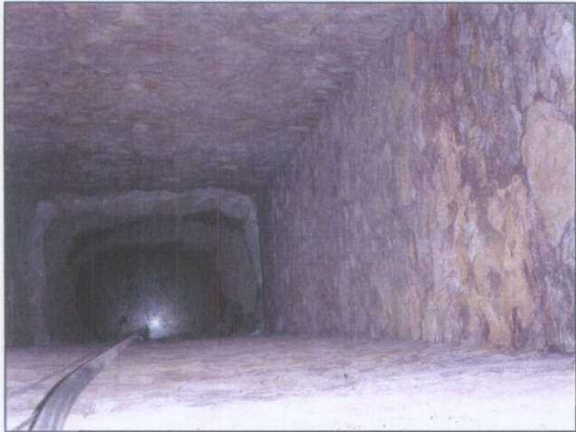
TV004.- Vista de la caña del pozo Maestro.
