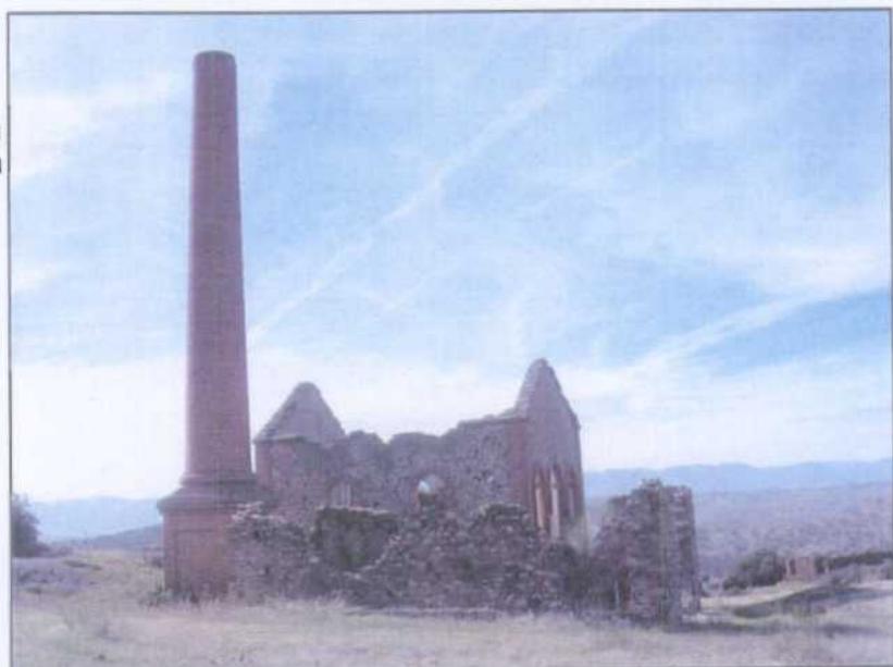
VB008.- Ruinas de la casa de la máquina de vapor y chimenea de humos.
