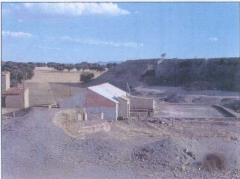
LV005.- Restos del lavadero de flotación. En la nave del centro se encontraban las celdas. Por delante esta la plataforma donde se apoyaba el silo de mineral machacado. A la derecha las eras de secado y a la izda. la caseta del transformador eléctrico.
