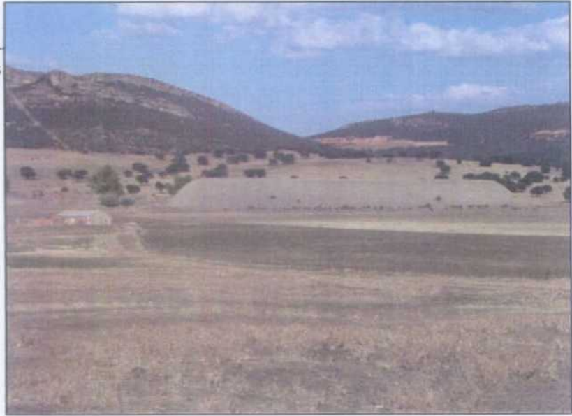
LV001.- Balsa de estériles del lavadero de flotación de los años 1970.
