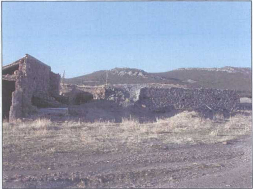
RM001.- Instalaciones del pozo San Luís.
