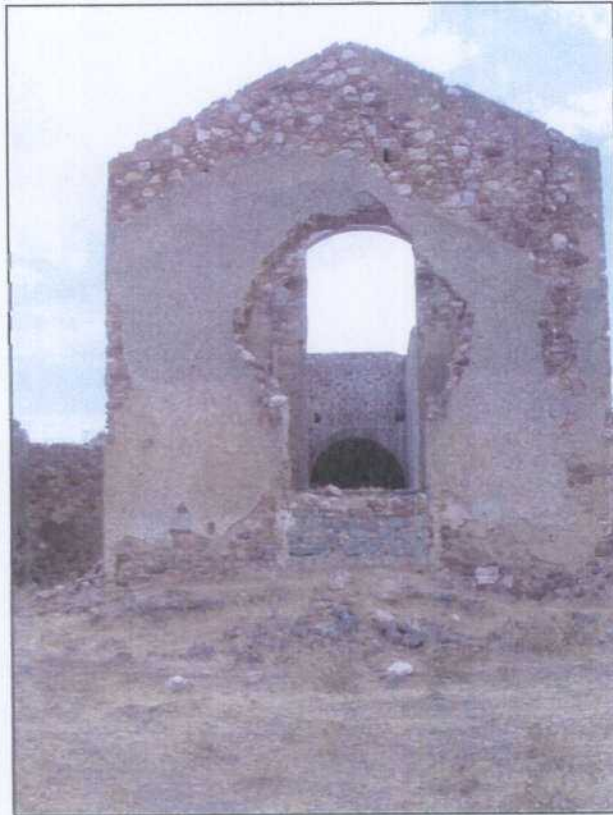
LR002.- Vista trasera de la casa de máquinas del pozo Maestro.
