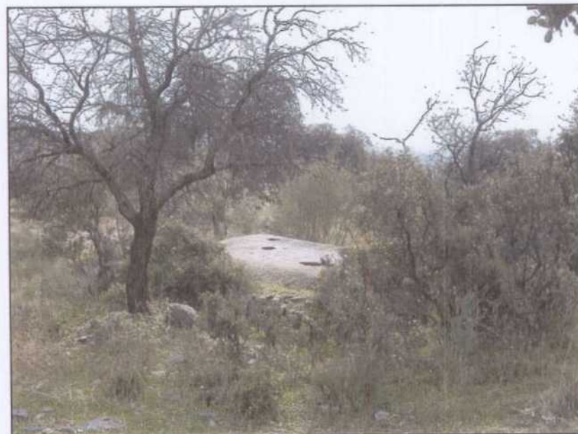
GJ031.- Pozo de poniente. Se halla tapado por una losa de cemento.
