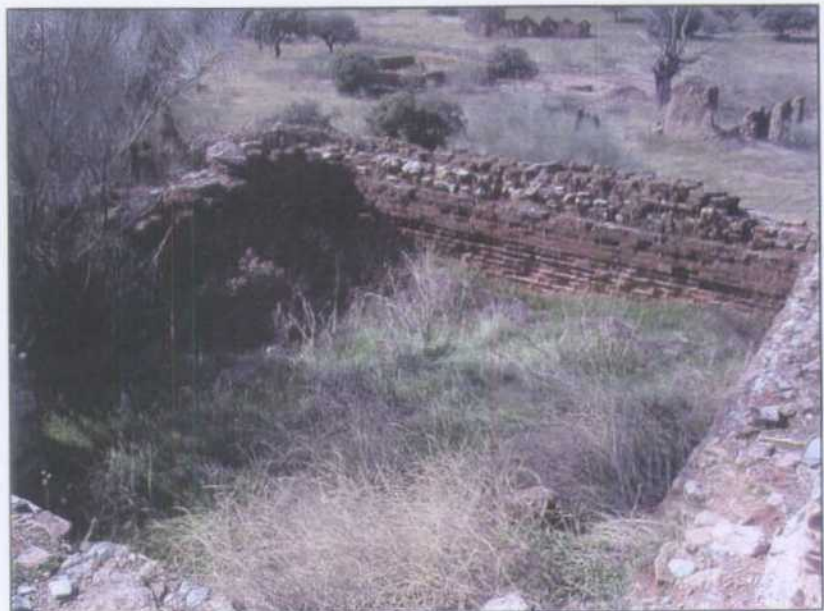
VB002.- Pozo Pepito. Depósito de recogida de agua del bombeo de la mina.
