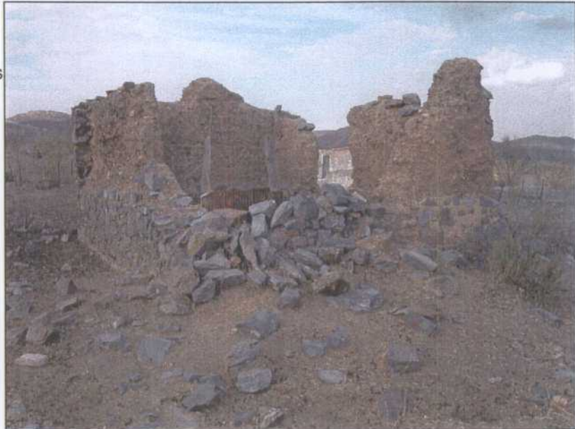
LH004.- Ruinas de edificaciones
