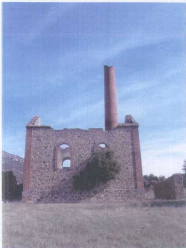
VB006.- Casa de máquinas del pozo Aldama. Vista lateral.
