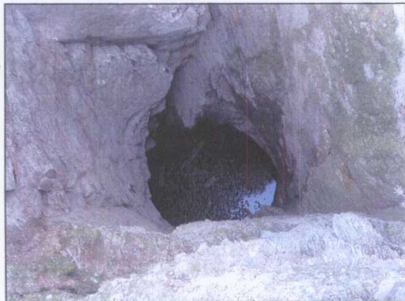
GJ019.- Chimenea con los hastiales colapsados. Vista de la caña.
