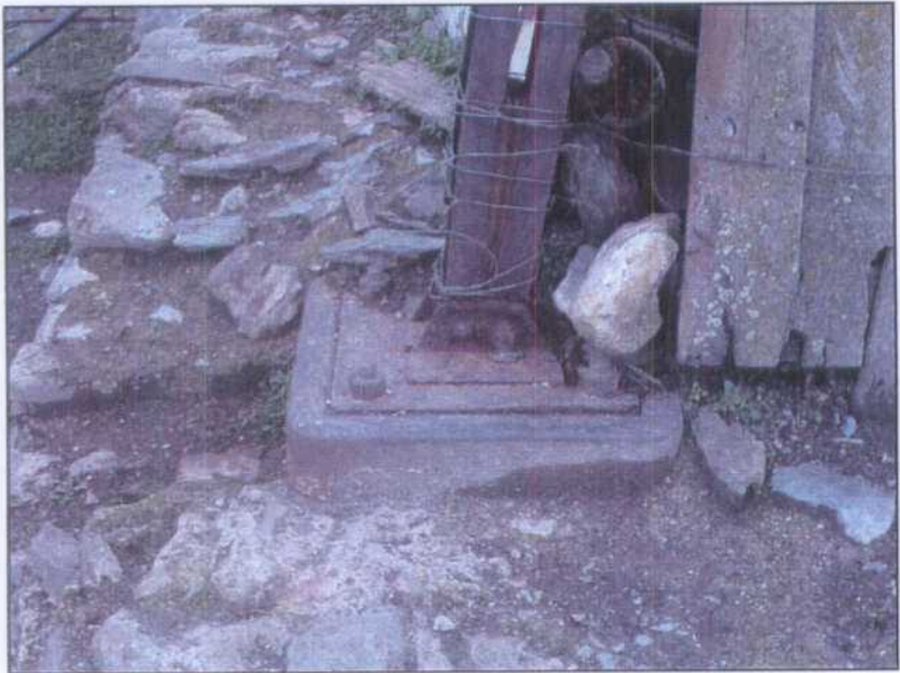
RB001.- Castillete metálico del pozo. Zapata metálica de apoyo de un pie trasero.
