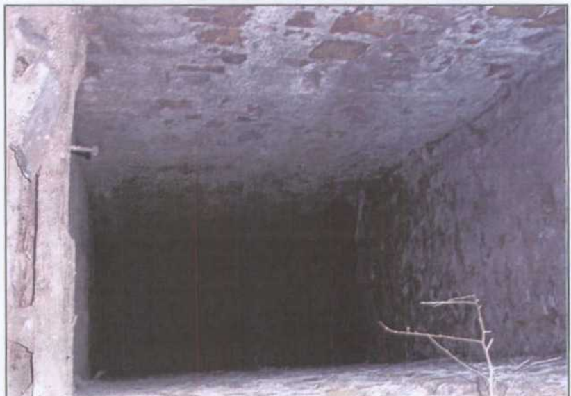
RM001.- Vista de la caña del pozo San Luís.
