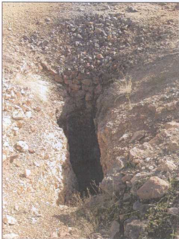
VE004.- Labor de explotación por realce parcialmente rellena.
