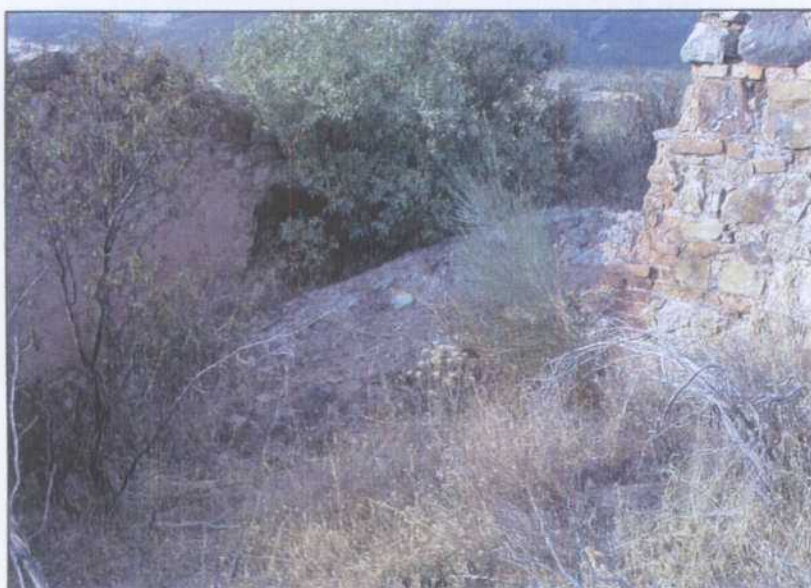
ML006.- Salida de humos y base de la chimenea.
