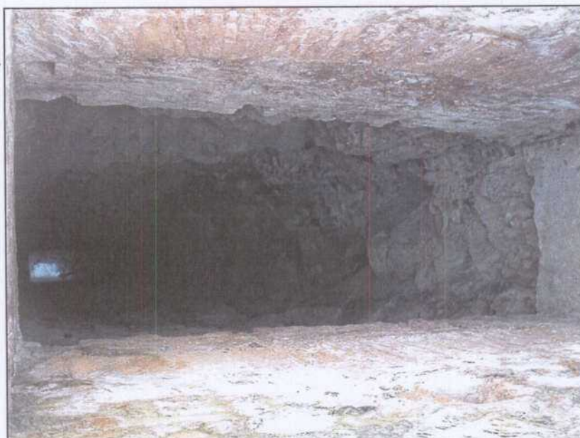
GT004.- Caña del pozo Maestro.
