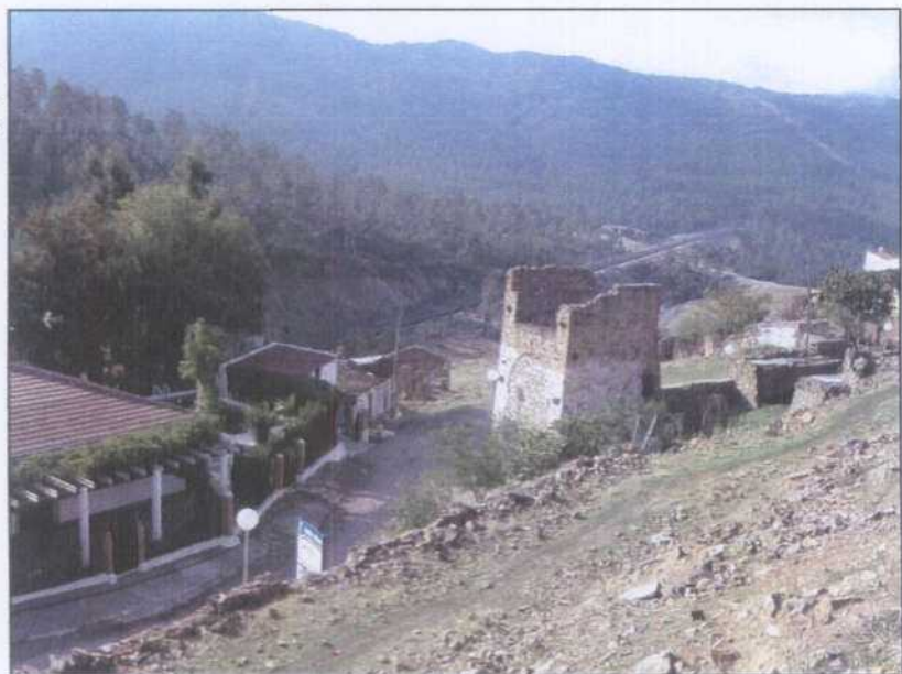
EH006.- El pozo San Miguel situado entre las casas de la aldea de El Horcajo. Al fondo se ve el ferrocarril AVE de Madrid a Sevilla.
