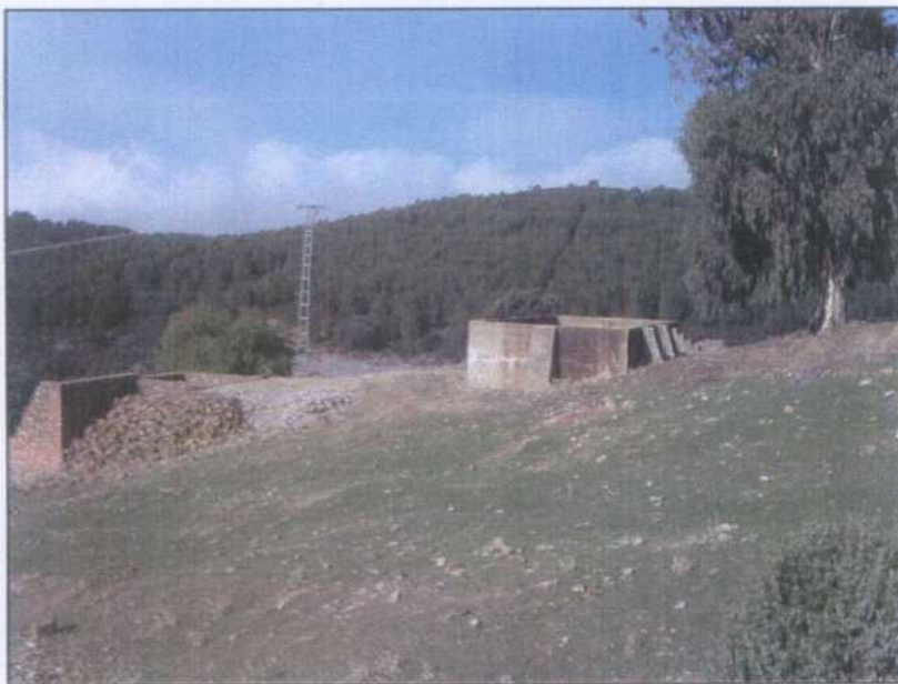
EH009.- Restos del lavadero de mineral de los años 50. Tolvas y depósito de agua.
