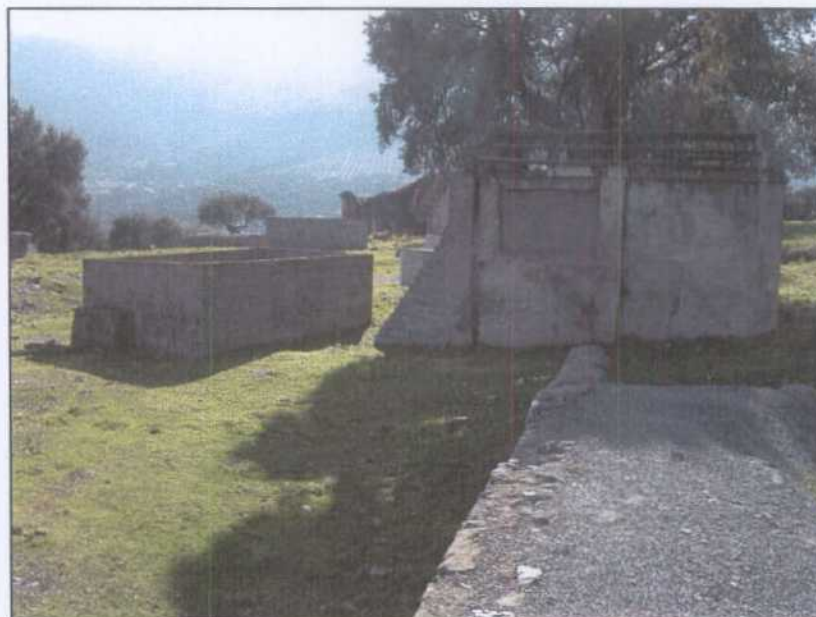
DG025.- Pozo auxiliar del nº 4 para la introducción de rellenos.
