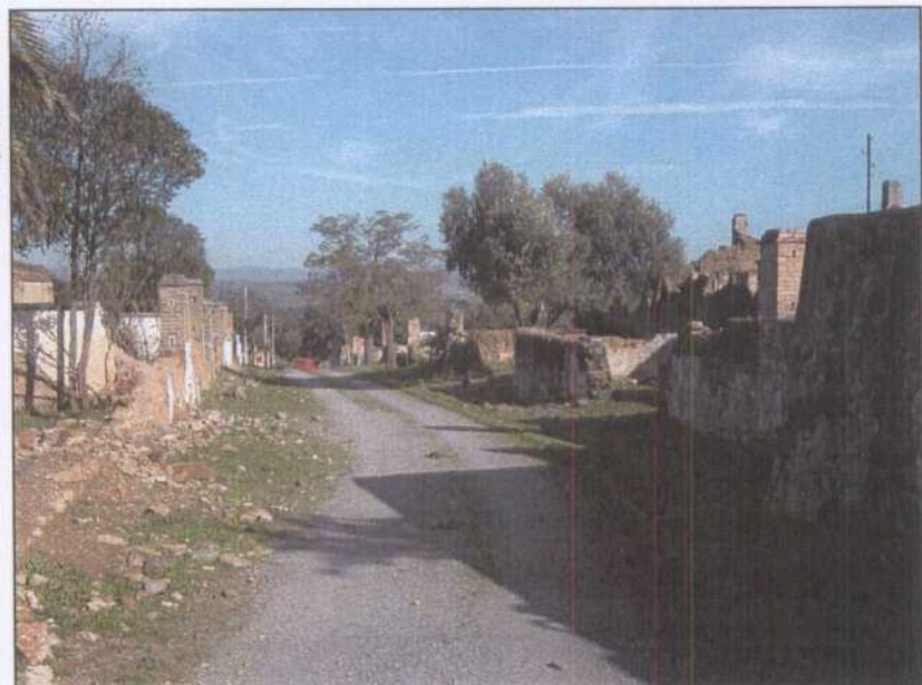
DG005.- Barriada de arriba del poblado minero. Estas casas estaban destinadas a los obreros cualificados .
