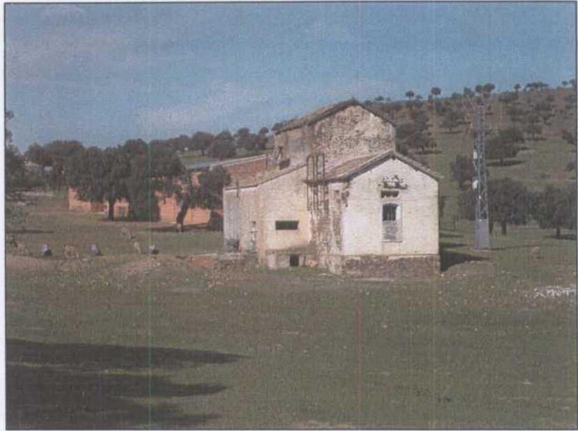
DG027.- Subestación eléctrica.
