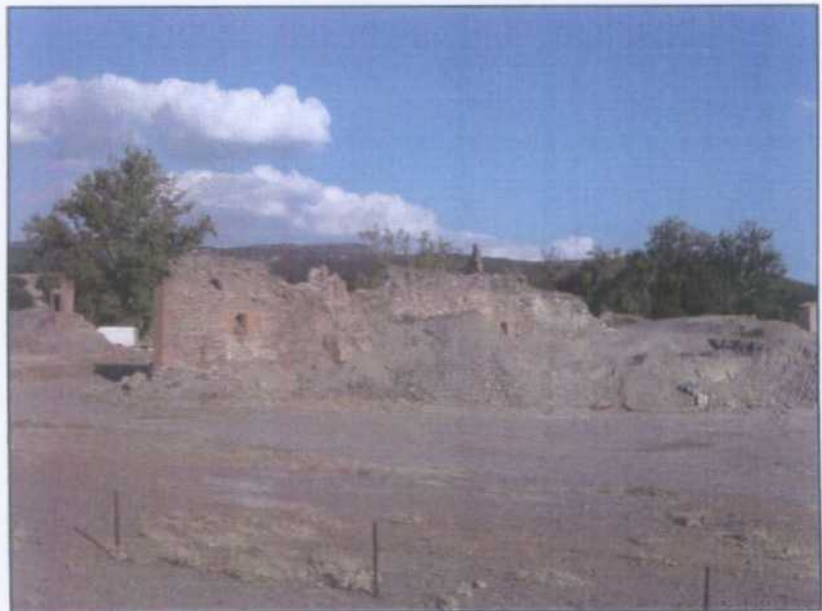
LV003.- Muros de las tolvas de descarga de mineral al circuito del lavadero antiguo.
