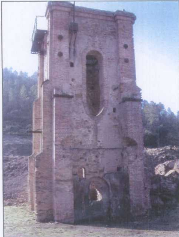
EH004.- Cabria de ladrillo y mampostería del pozo Argentino. Vista lateral.
