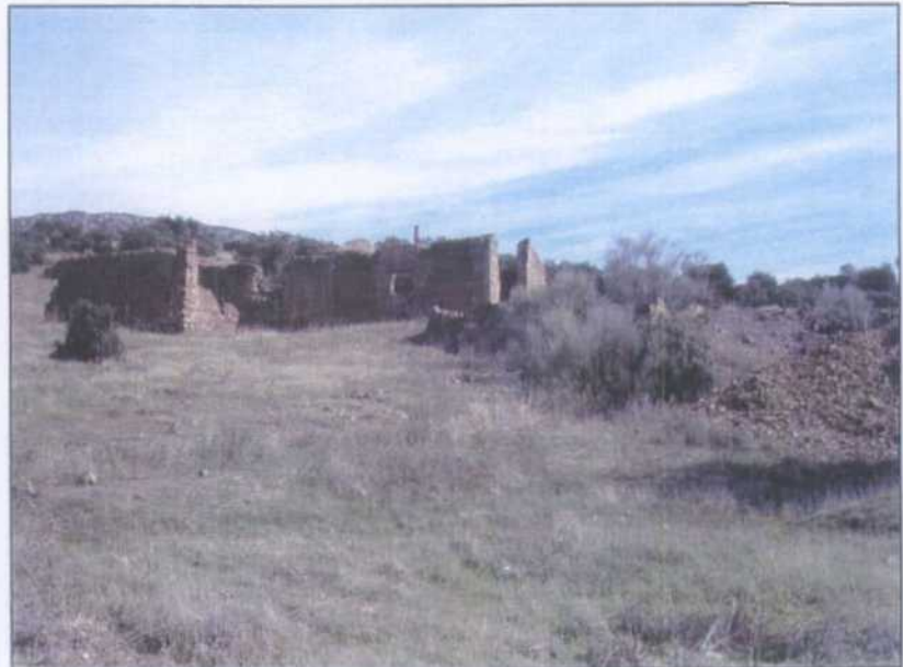
VB002.- Pozo Pepito. Vista de las instalaciones.
