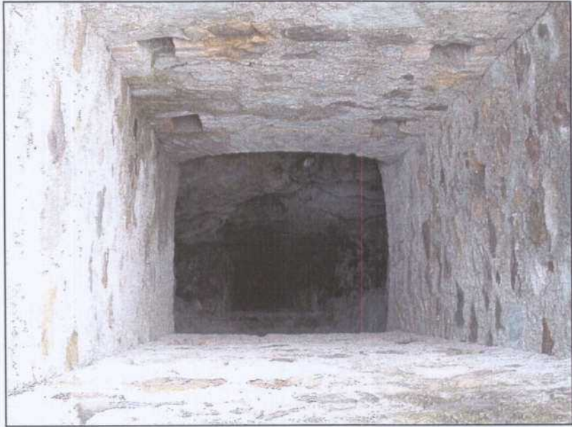
GT012.- Chimenea de levante. Vista de la caña del pozo.
