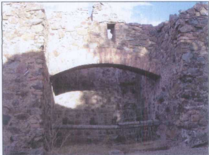
LJ002.- Ranura realizada en la estructura del pozo Esperanza para el paso de un cable de un cablestante instalado en la reapertura de la mina a mediados del siglo XX.
