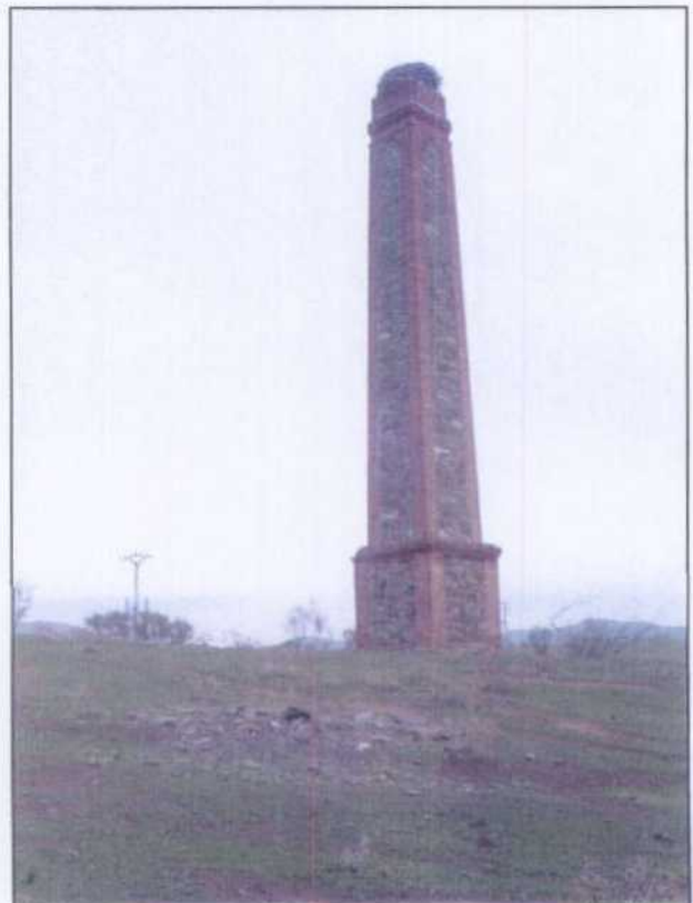
SB001.- Chimenea de humos. Vista desde el este.
