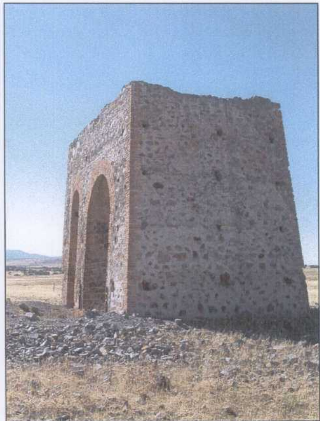
DL001- Estructura superficial del pozo de la mina. Vista trasera.
