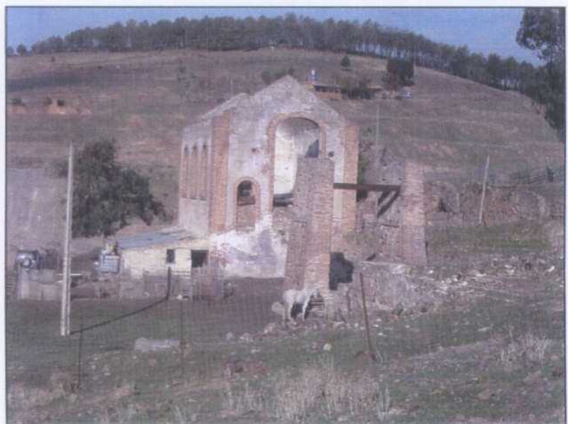
EH002.- Vista del pozo Malacate con la casa de máquinas detrás de la cabría de mampostería.
