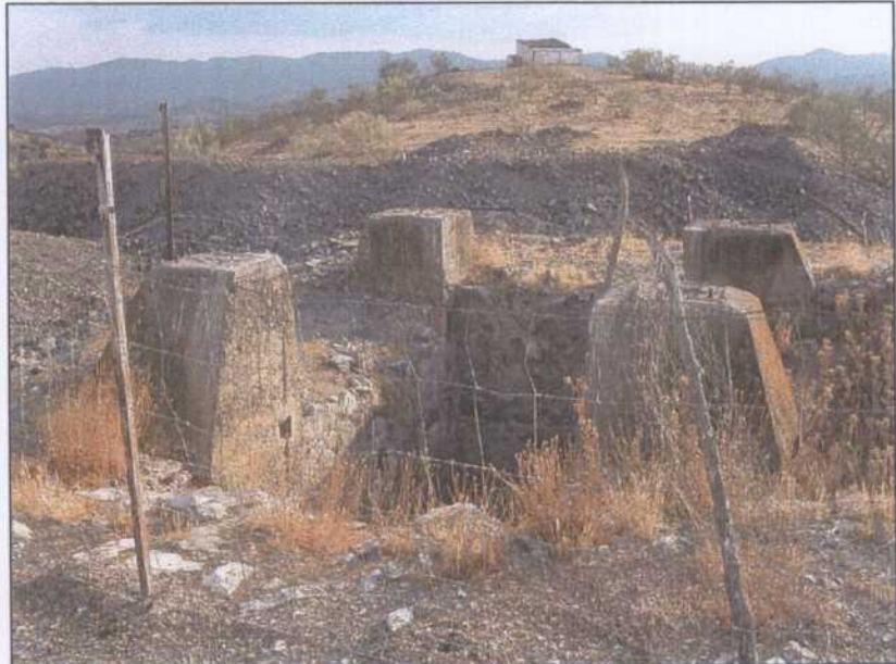
LH007.- Emboquille del pozo Armstrong, Se pueden ver las zapatas de asiento del castillete de los años 1950..
