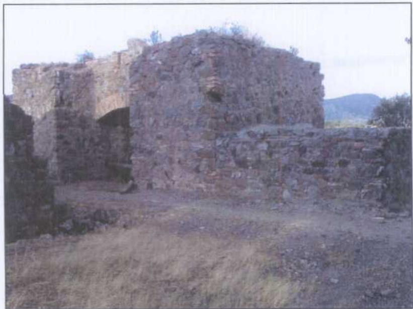
LJ002.- Vista frontal de la estructura del pozo Esperanza.
