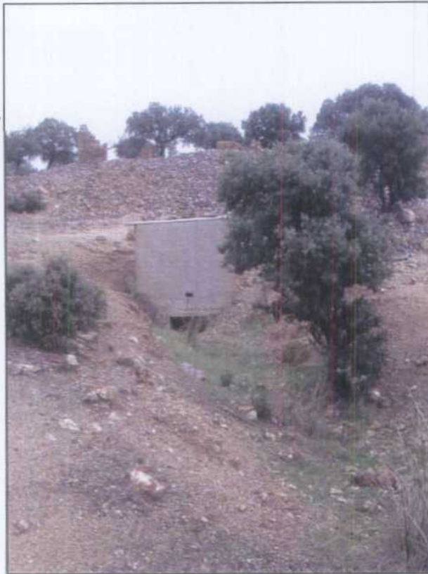
PZ001.- Entrada al socavón de poniente, actualmente utilizado para sacar agua.
