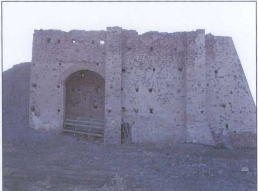
RM006.- Pozo Santa Bárbara.
