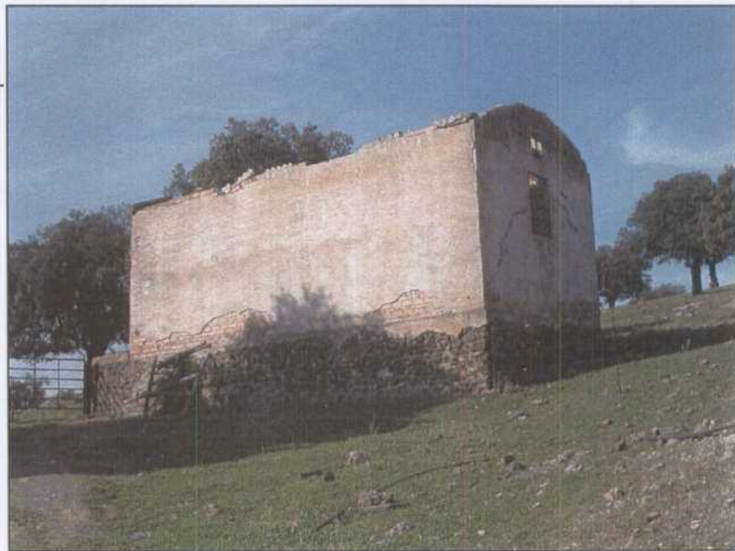
DG020.- Caseta del transformador eléctrico.
