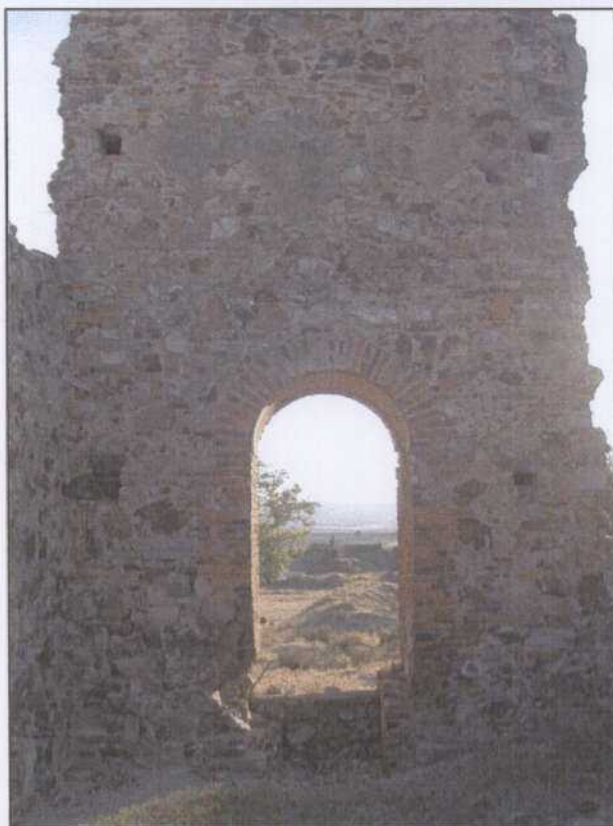
LV008- Ruinas de talleres y edificios auxiliares. Detalle del ventanal.
