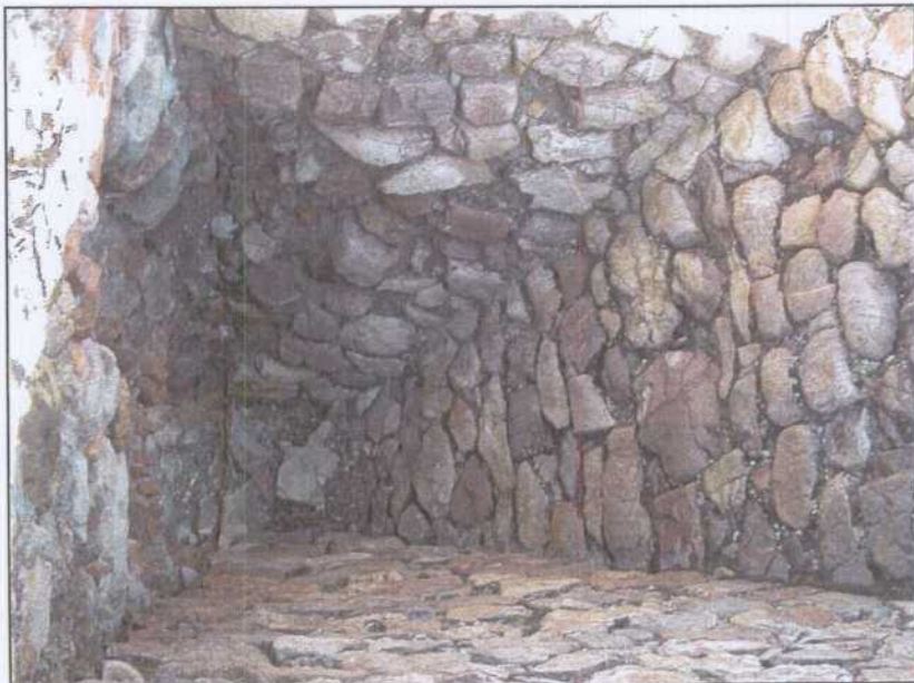
GT003.- Lavadero antiguo. Tolva construida con muros de mampostería.
