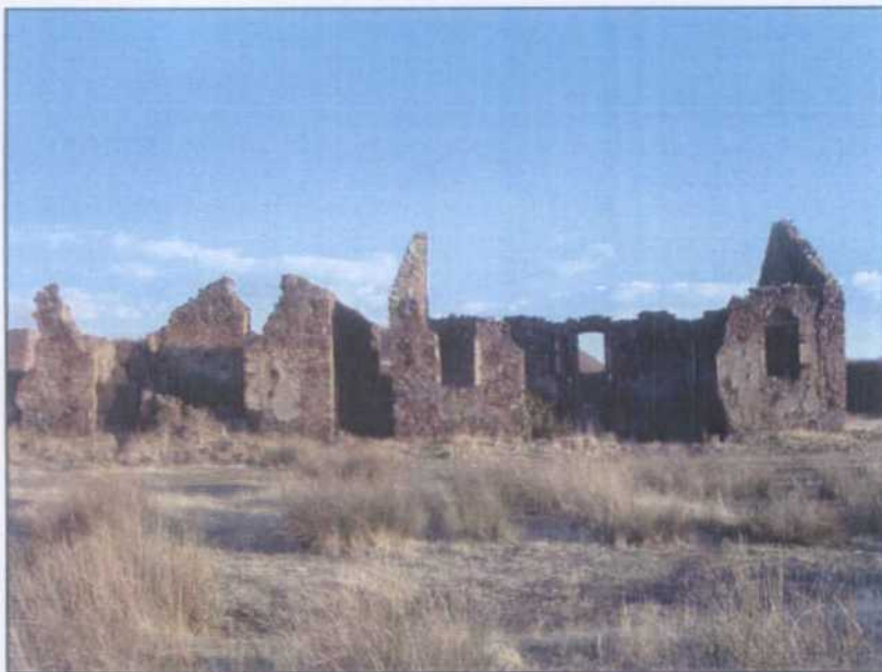
EP006.- Casa de la máquina de extracción del pozo La Perrera.
