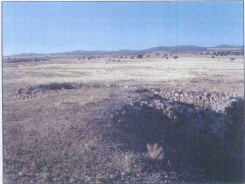
EM006.- Tolvas de descarga de minerales junto al pozo de po niente.
