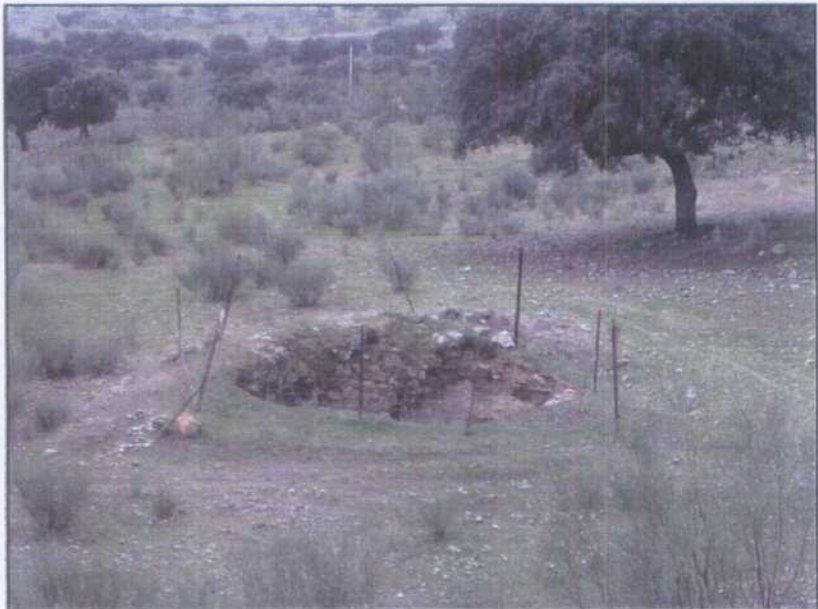
GJ019.- Chimenea con los hastiales colapsados.
