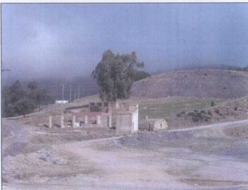
EH009.- Restos del lavadero de mineral instalado en la década de los 1950.
