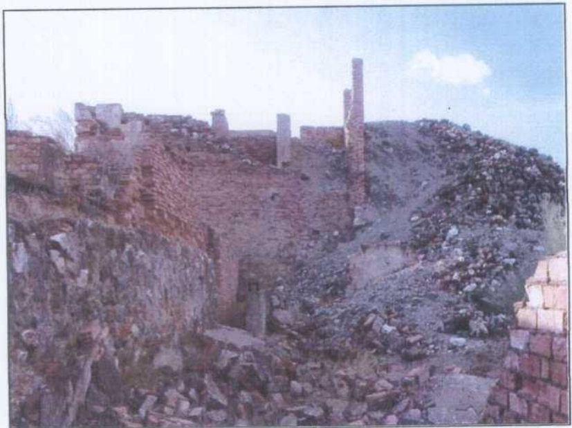
LP003.- Tolvas de descarga de vagonetas desde el pozo Mi Angel.
