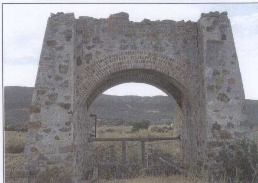
LJ013.- Vista trasera de la cabria del pozo Buen Acuerdo, con el embarque del nivel de descarga.
