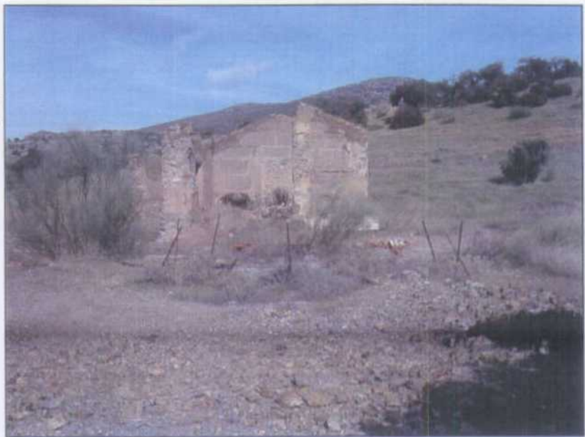
VB002.- Pozo Pepito. Emboquille del pozo y casa de máquinas.
