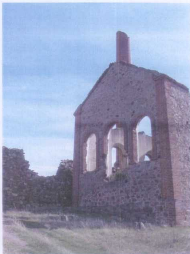
VB006.- Casa de máquinas del pozo Aldama. Vista trasera.
