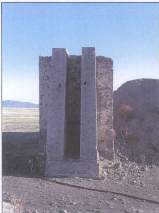
RM006.- Contrafuertes de apoyo de los Pies inclinados Santa Bárbara.
