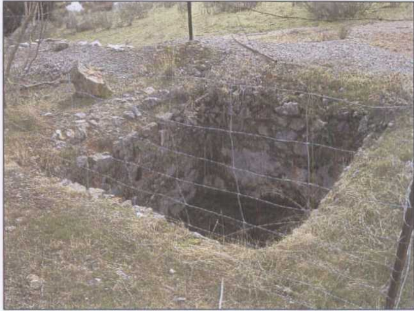
GJ029.- Pozo auxiliar revestido.
