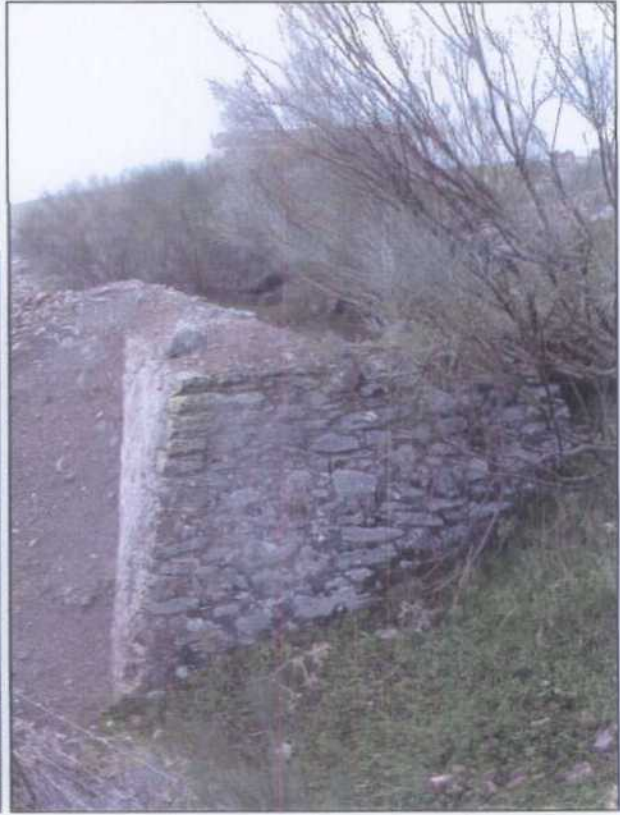
SB002.- Restos del depósito de agua.
