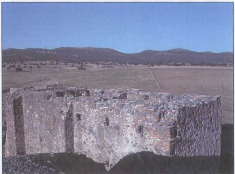
RM006.- Estructura del pozo Santa Bárbara. Tiene tres compartimentos, situándose el pozo en el central.
