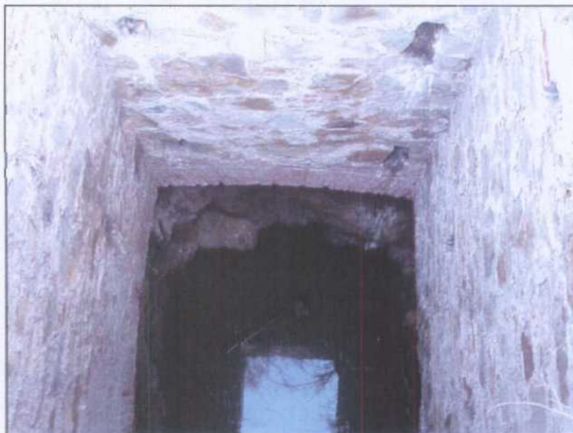
GJ026.- Caña del pozo Central.
